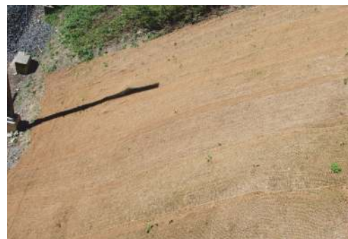
Geotessili - Sifor ® di cocco appena posata.
